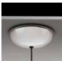
Led- ohjain kattokupissa. Sähkönsyöttö pohjasta.
